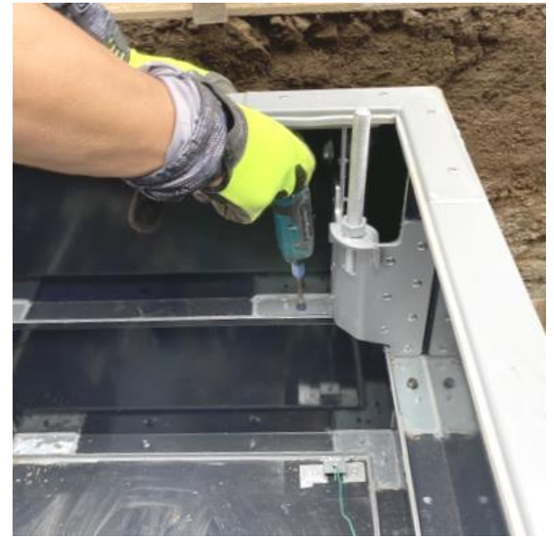
⑨ GLに合わせて高さ、角度調整
