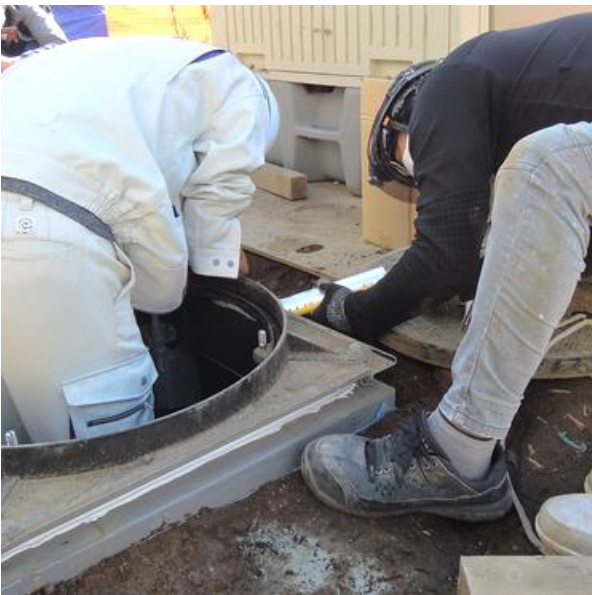
⑩ 調整部隙間にシーリング
