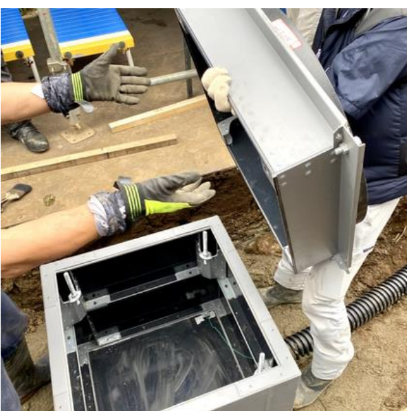
⑩ 調整部隙間にシーリング
